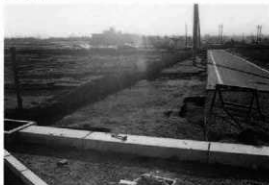
拡張区 全景 (西から)
