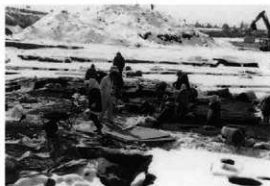
作業風景 (西から)
