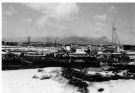
作業風景 (東から)
