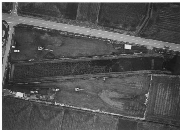
浜川高田 Hr-PP下水田 5~16区 全景
