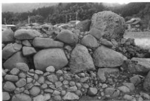
玄室東壁崩落状態
