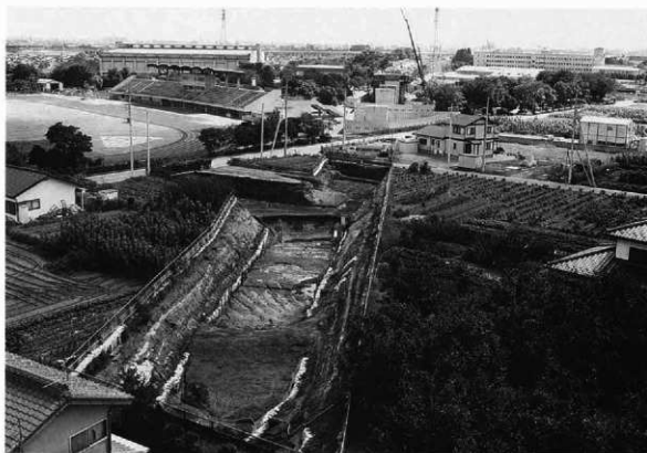
No 7エリアHr-FA下面全景（北西より）
