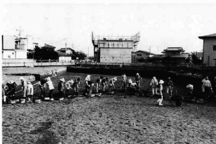
調査風景 (No 3 エリア)
