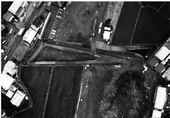
No 4エリア・No 5エリアHr-FA水田全景
