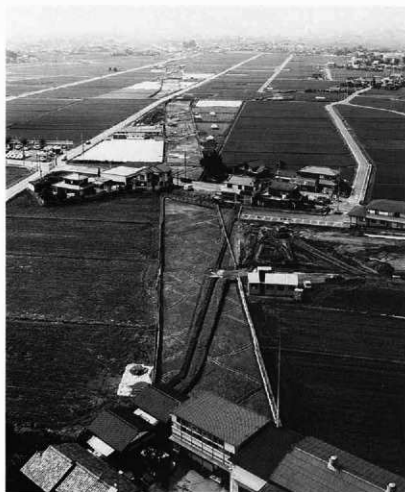
No 4エリア・No 5エリアAs-B 下水田全景（南東より）
