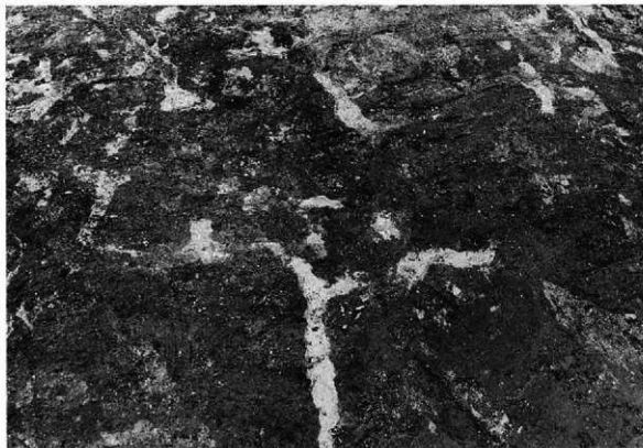
No 7 エリアHr-FAT地割れ
