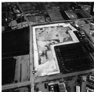
五反田地区H-r-F A (VI)層下全景(斜め 西から)
