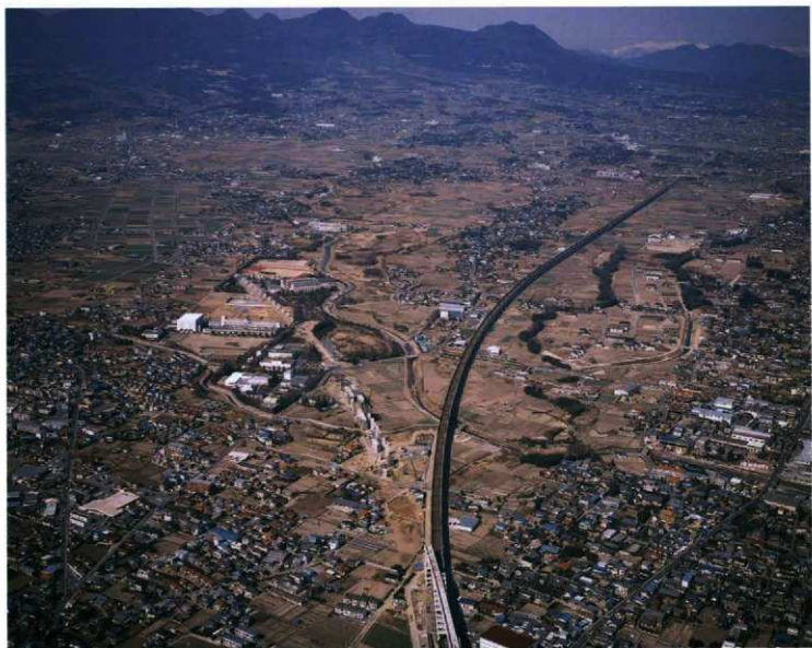
道路周辺航空写真
