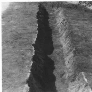
10号道路 掘り上がり (東から)
