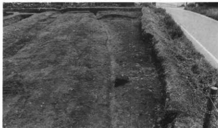
06号道路 掘り上がり (東から)
