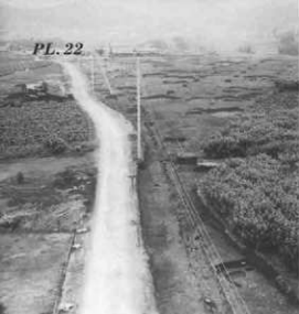
05号道路 全景 (北から)
