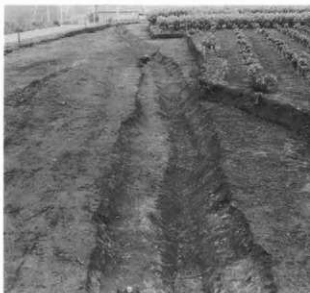
05号道路 掘り上がり (西から)
