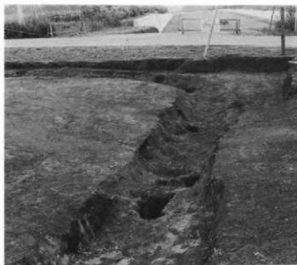
05号道路 掘り上がり (南から)
