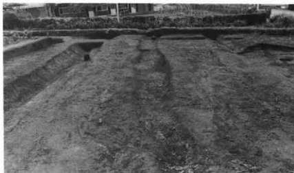
06号道路 掘り上がり (東から)
