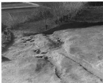
01号不明遺構 掘り上がり (東から)
