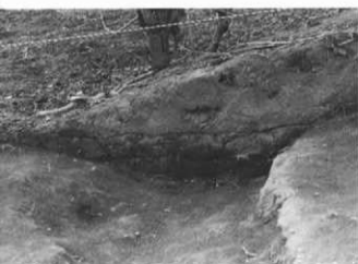
01号不明遺構 セクション (東から)
