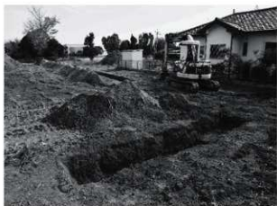
5 トレンチ調査状況 (西から)
