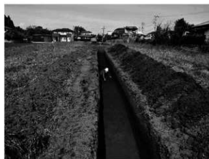
2 トレンチ調査状況 (北から)
