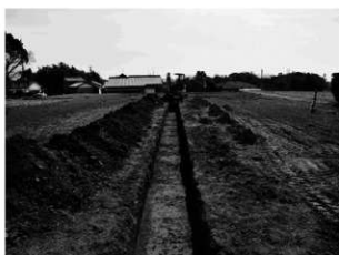
3 トレンチ調査状況（北から）
