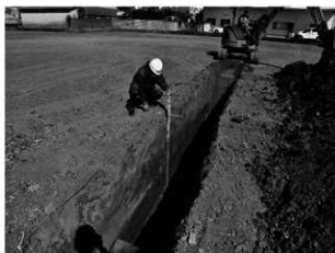
2 トレンチ調査状況 (南東から)
