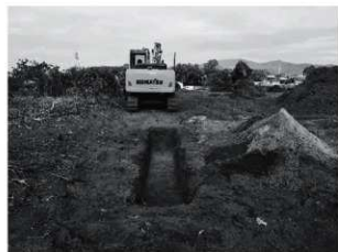
6 トレンチ調査状況 (南東から)
