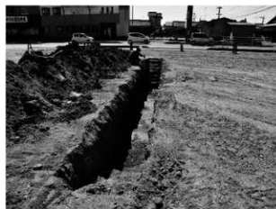
1 トレンチ調査状況 (北から)
