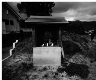
西林坊の整備完了後
