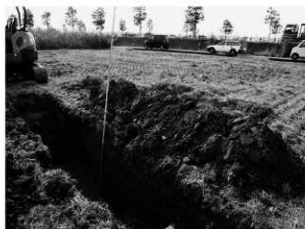
435-1 番地トレンチ調査状況 (北西から)
