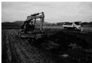
写真1 重機によるトレンチ掘削状況
