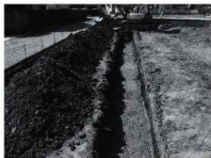
写真6 岩崎原遺跡調査状況 (北から)
