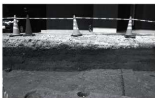
4. 321次 西壁壁面（東から）
