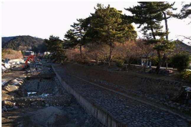
(2) 26-2 トレンチと平等院観音堂(北西から)
