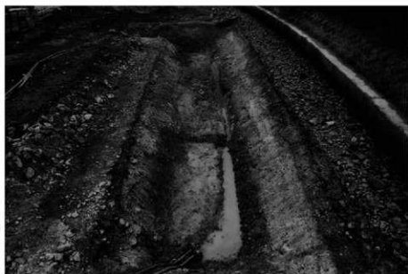
(3)24-2 トレンチ完掘後全景 (北西から)
