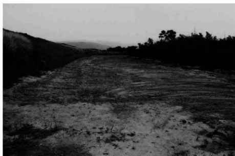
(2) 第 1 トレンチ埋め戻し状況 (南東から)
