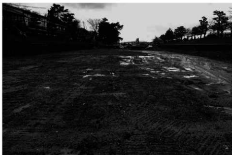
(2)平成26年度調査終了状況 (南東から)
