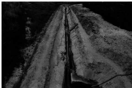
(1) 第1トレンチ全景(南東から)
