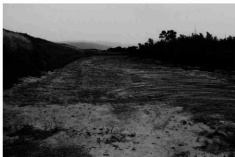
(2) 第 1 トレンチ埋め戻し状況 (南東から)
