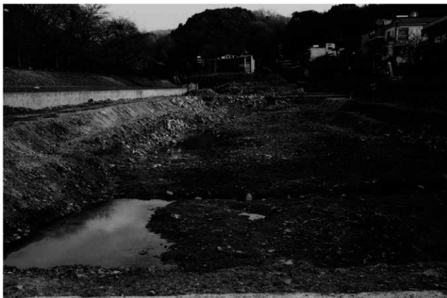
(2)26-5 トレンチ堤状遺構 S X01 確除去後状況(北西から)
