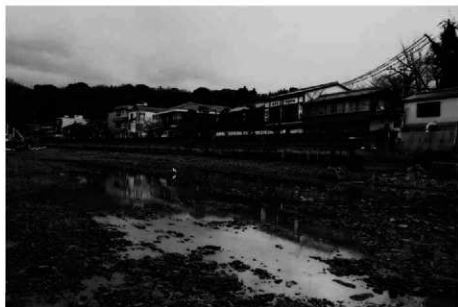
(2) 調査前全景(北東から)
