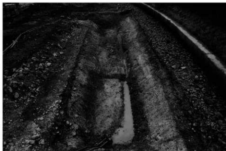
(3)24-2 トレンチ完掘後全景 (北西から)
