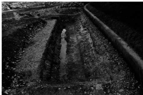
(3)24-3 トレンチ完掘後全景 (北西から)
