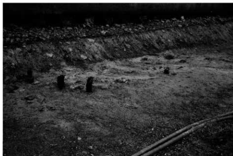
(2)24-3 トレンチ杭列検出状況 (東から)
