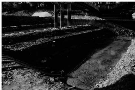
(2)24-1 トレンチ断面(北から)
