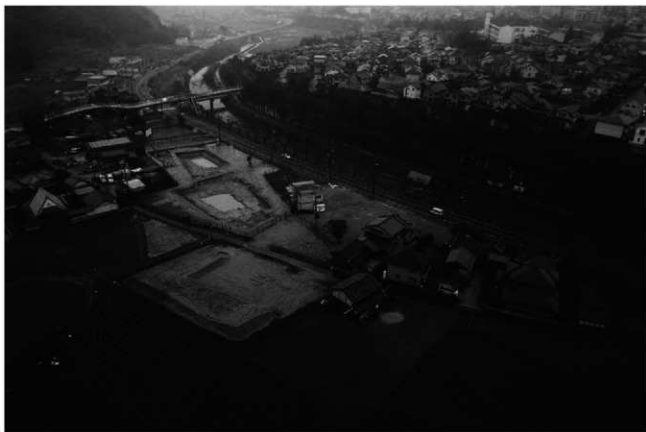
(2) 調査地遠景(北西上空から)
