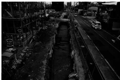
(3) 調査掘削中 (北部より溝を検出、北から)
