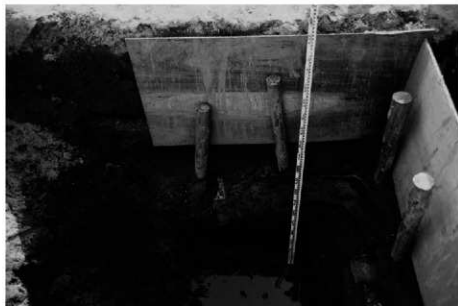
(1) 第3グリッド下層調査 (北東から)
