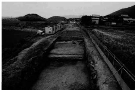
(2) 第18次調査第3区掘削状況 (南東から)
