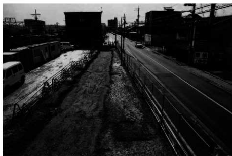
(3) 調査完了状況(北から)
