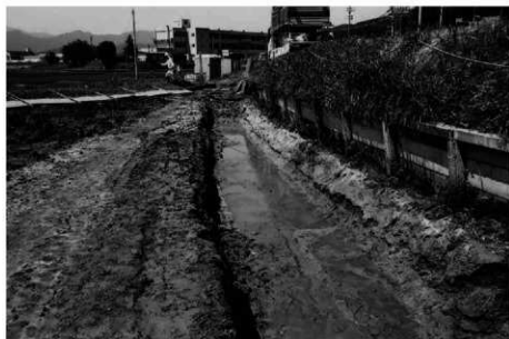
(2) トレンチ掘削状況(北東から)
