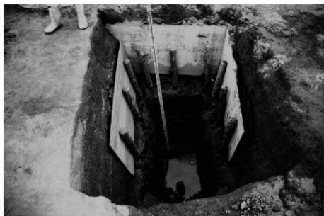
(2) 第4グリッド下層調査 (南東から)
