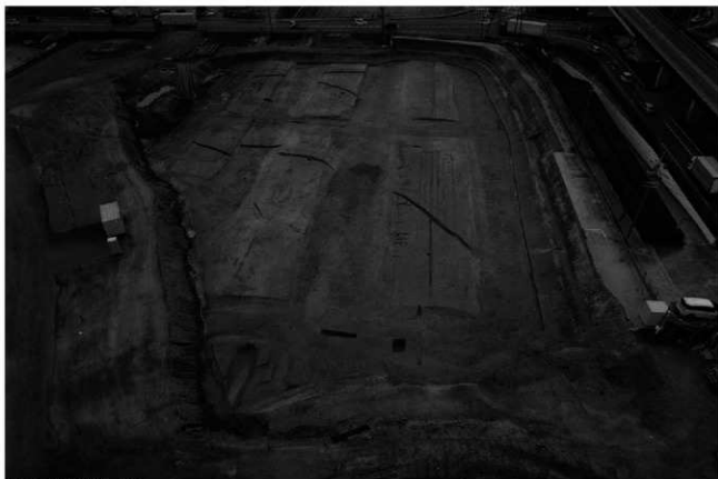
(1) C 2 区全景(北から)
