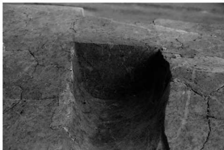
(1) A3区溝SD22土層断面 (南西から)
