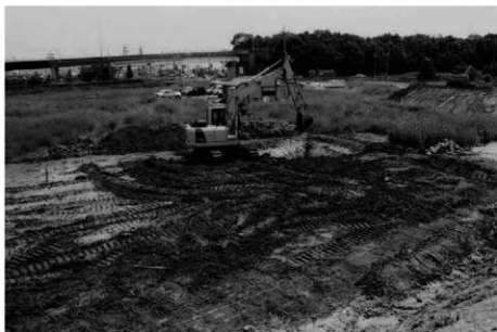
(3) E 5区重機掘削(北西から)
