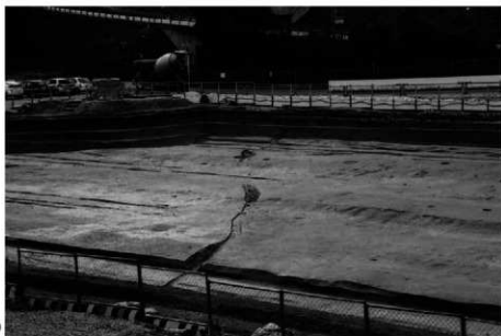
(2) A3区溝S D24全景(北東から)
