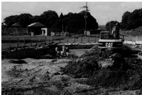
(1) B 2 区重機掘削(北から)
