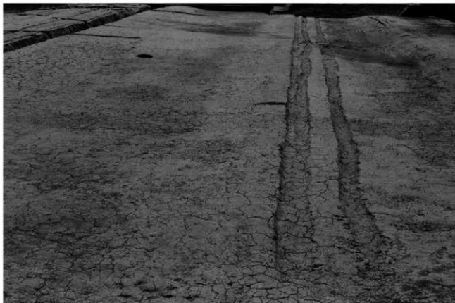
(1) C 1 区島畑19全景(南から)
