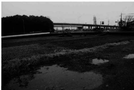
(1) A1区重機掘削(南東から)
