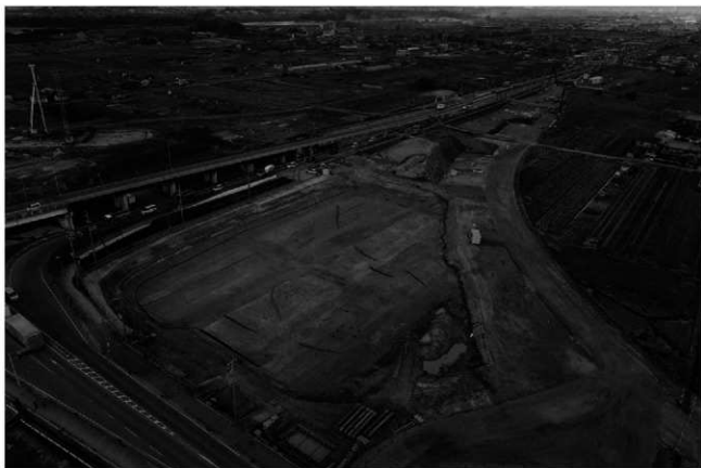
(1) C 2 区全景(南東から)
