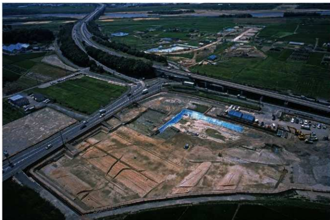
(2)水主神社東遺跡第5次C1区全景(北東から)
