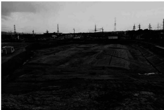
(1) C 2 区全景(北から)
