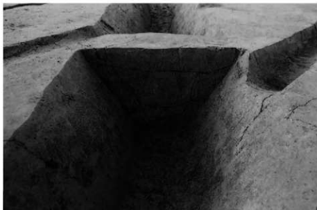
(2) C 2 区溝 S D 407 土層断面 (南東から)
