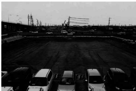
(1) A3区島畑27～29全景 (南から)
