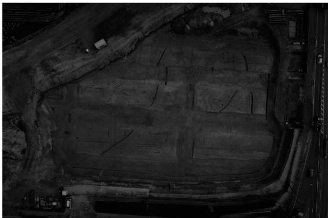
(2) C 2 区全景(上が東)
