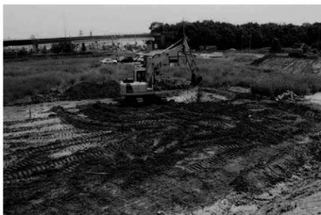
(3) E 5区重機掘削(北西から)
