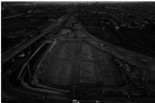
(1) C 2 区全景(南から)
