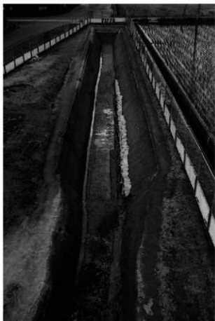
(1) B 1 区全景(拡張前、南から)
