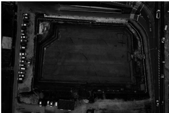
(2) A3区全景(上が西)
