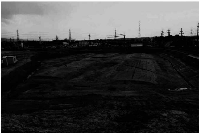
(1) C 2 区全景(北から)
