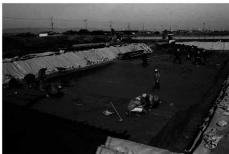
(3) E 1 区作業風景(南東から)
