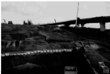
(1) 6 トレンチ遠景(南から)
