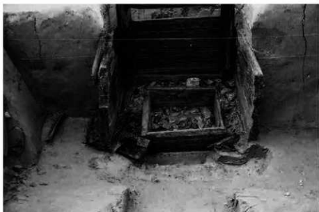
(2) F 7 区井戸 S E 0704 解体状況 (南から)
