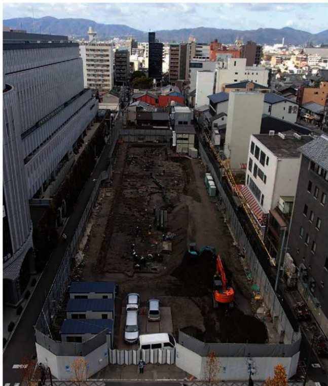
調査地全景(東から)
