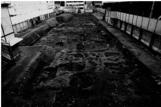
(2) 第2・3調査区 第3調査面全景(西から)
