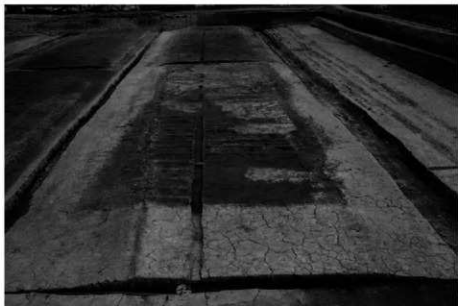
(1) O1区島畑91全景(南から)
