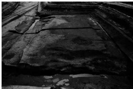
(1) L2区島畑72全景(北から)
