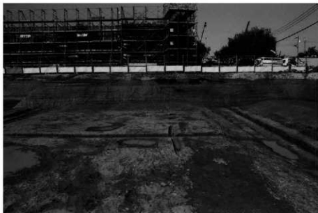
(1) O2区北壁(東半部)土層断面 (南から)
