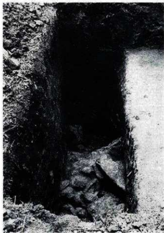
▼3. トレンチ1 深掘り
