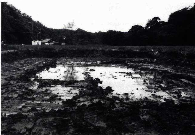
▲1. 重機による掘削終了直後
