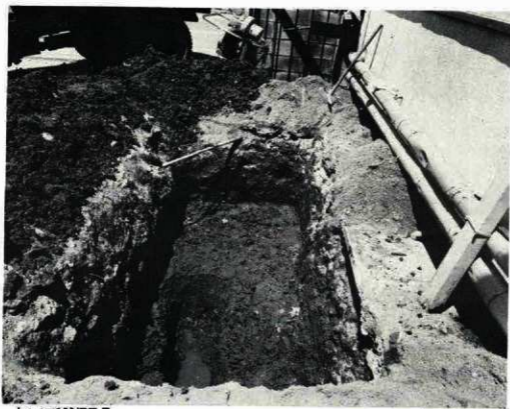
トレンチ試掘風景
