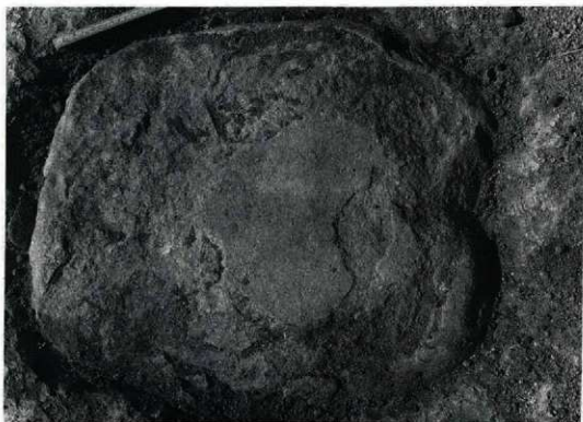
礎石上面柱根部
