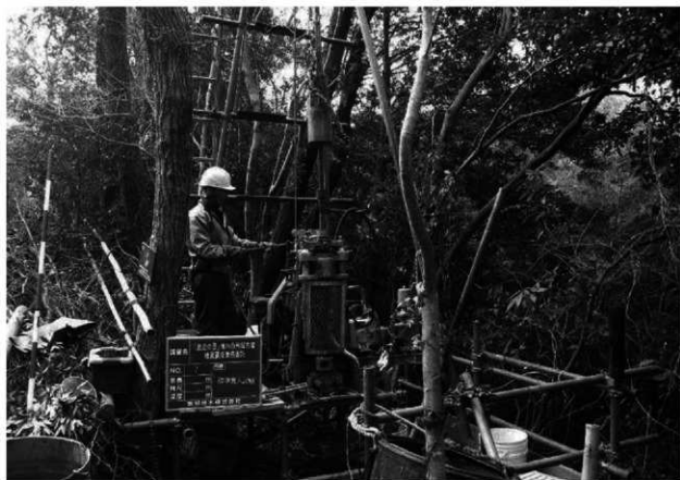
2 平成30年度No1標準貫入試験作業風景
