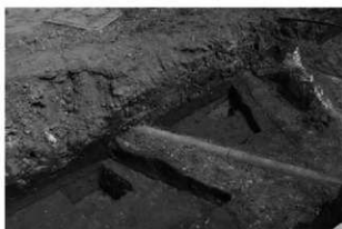
13 19トレンチ北壁（南西から）
