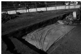
77 11 トレンチ転落石養生（下は山砂と土糞）
