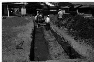
10 18トレンチ 掘削状況（西から）
