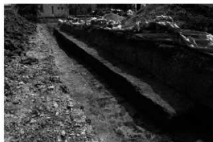
4 16トレンチ全景（北東から）
