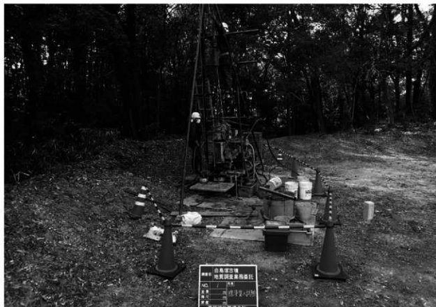
1 平成29年度No1標準貫入試験作業風景
