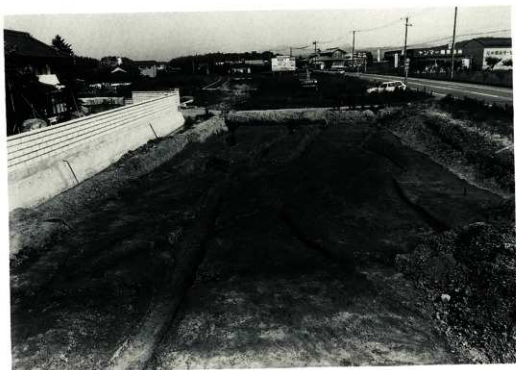
北地区東半部 (北西方向から)
