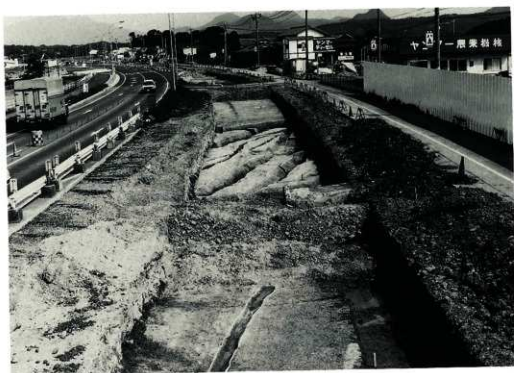
北地区(現道部)溝 (北西方向から)
