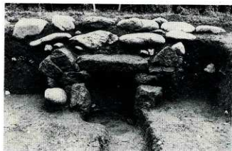
SD1 開口部 (排水口)
