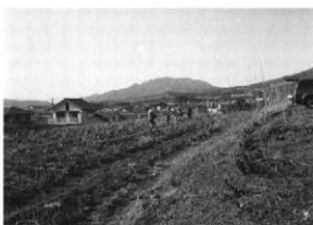
写真250 電磁波探査作業状況
