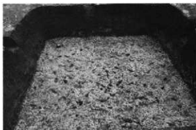
写真229 床面の状態(北東から)
