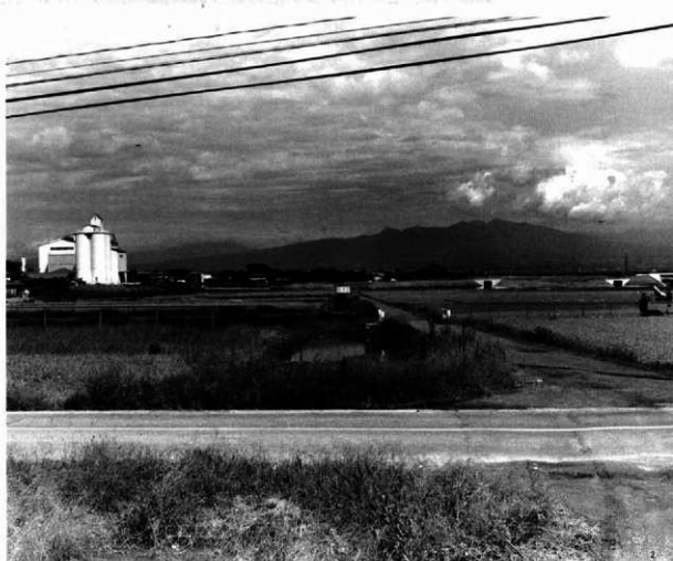
2. 緑地遺跡群・遠景 (南から)
