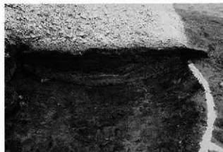
3区西 3号溝断面
