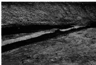
1区西 遺構確認状況
