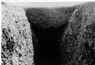
3区西 1号溝断面
