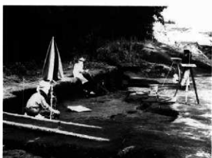
町道拉幅 北側測量作業風景
