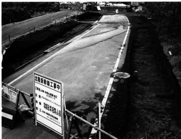
町道拡幅 1-149 拡幅部分全景
