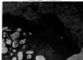
62号住居西壁挟り込みの状態
