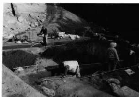
発掘調査風景（北西から）
