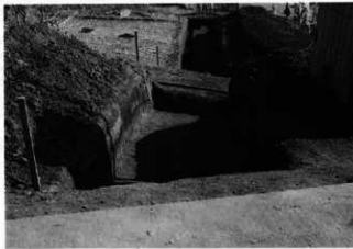
3 北トレンチ全景 (西から)
