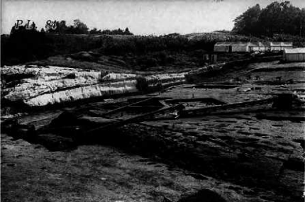
107・130・188号遺構 掘り上がり（北から）
