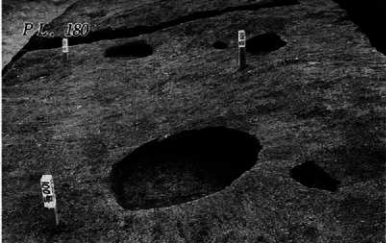
100・101・102 (手前から)号遺構 掘り上がり (北から)
