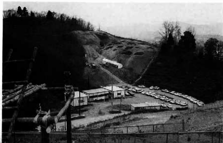
庚申山地区 掘り上がり 手前は仮復元の 斜面掘立
