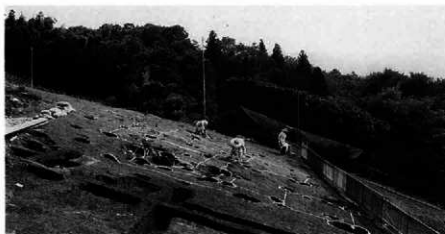
転落防止柵上の掘立
