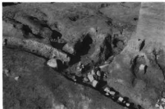
2号溜井 全景 (南東から)
