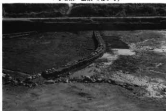
5号暗渠 全景(北から)
