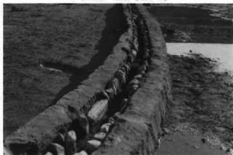
5号暗渠 天井石除去後(北から)
