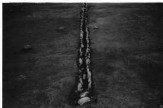
2号暗渠 天井石除去後(北から)
