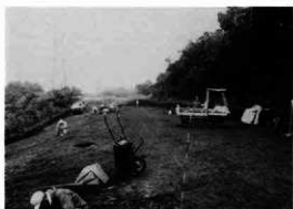
陥穴集中部分作業風景（傾斜変換部）
