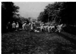
作業風景（23号陥穴付近より）
