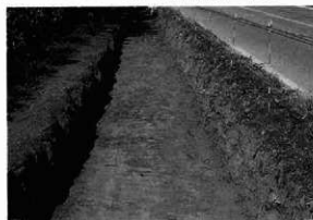
01-920067-18 1区-5 全景 南から
