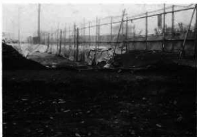
01-910028-01 土塁南北セクション 西から
