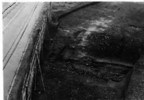
10-910007-08 堀・土塁 東から
