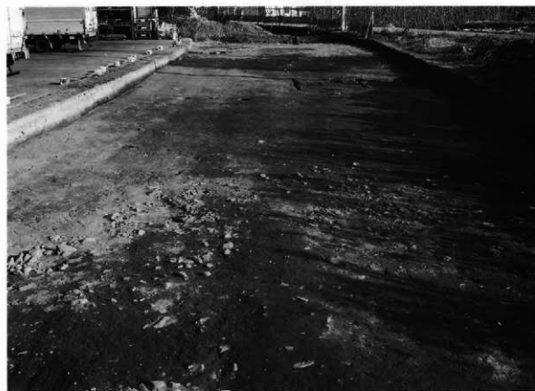
10-91014-09 ビット群全景 西から
