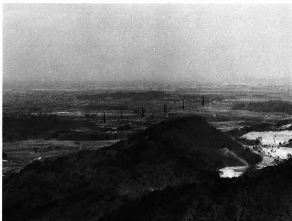
供用・改良工事中の県道神田・吉井線停車場遠景
