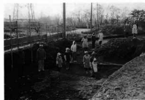
10-910015-03 堀・土塁 東から
