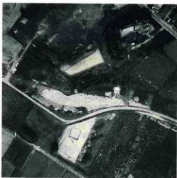
調査区全景（上空より）
