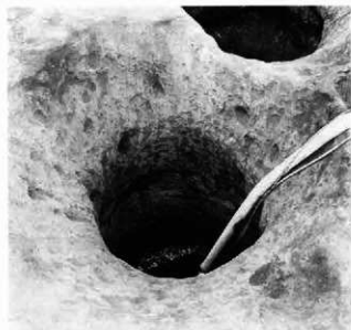
D187 (北西から)
