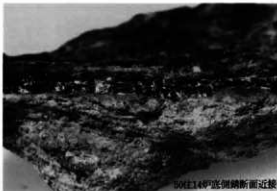
50住 140°底側割断面近景
