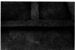
5. BPの落ち込み確認状態
