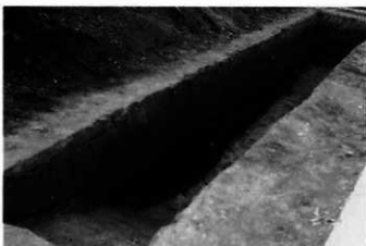
8 11トレンチセクション
