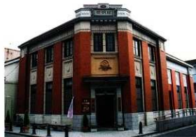
隈まちづくりセンター黎明館
