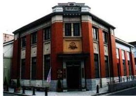
隈まちづくりセンター黎明館
