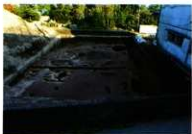
Ⅱ区全景 (西から)
