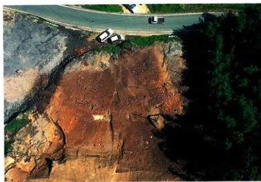
北東斜面全景 (真上)
