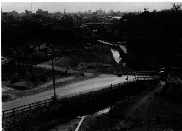
1. 1区から下流部方向市街地を望む（北西から）
