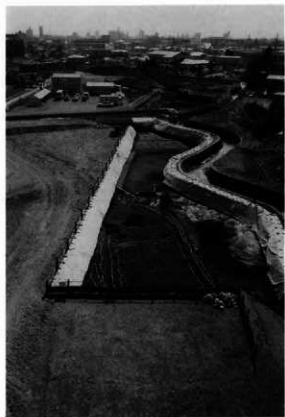
1. IV区5面 全景 (北西から)
