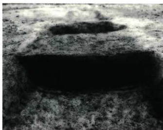
溝掘り下げ状況
