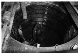
下層掘削状況 (東から)
