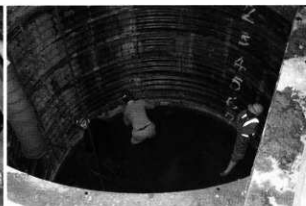
下層掘削状況 (東から)
