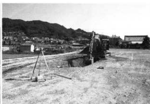
機械掘削状況(北西から)
