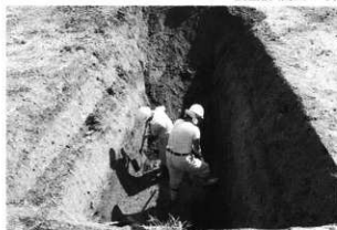
1区人力掘削状況(北から)
