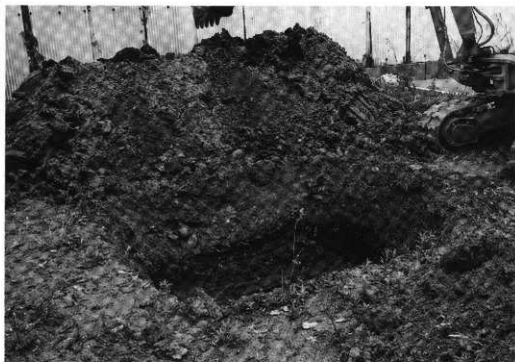
T1 調査状況(南から)
